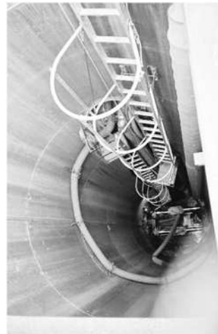
【作業員昇降時】
